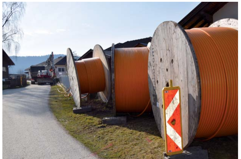
Zügig geht der Glasfaserausbau voran.
